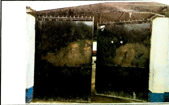
Foto 6: Mantenimiento a portón de metal
