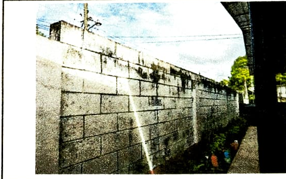
Foto 4: Pintura en muros exteriores e interiores
