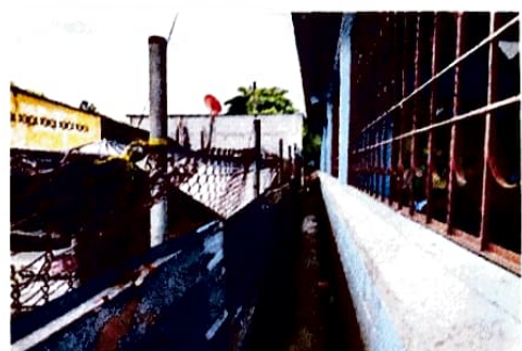
Foto 9: Reparación de tubo hg y malla galvanizada
