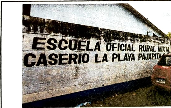
Foto 3: Pintura en muros exteriores e interiores
