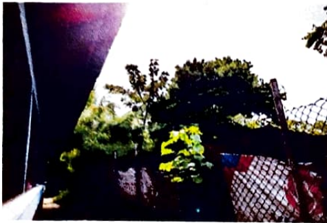
Foto 8: Reparación de tubo hg y malla galvanizada
